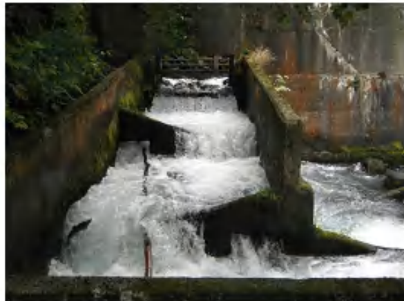
改良前の魚道
