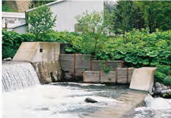
改良前の魚道
