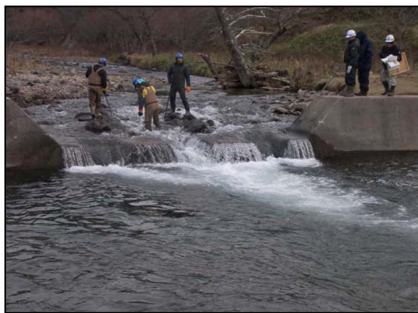
No.3 床固工(ルシャ川)
