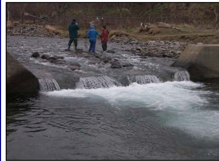
No.4 床固工(ルシャ川)
