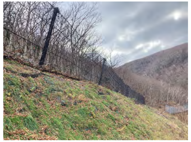
②落石防護柵（リングネット工）
