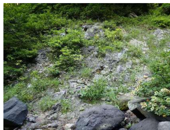
⑧三の滝直下の割れ目の発達した岩盤
