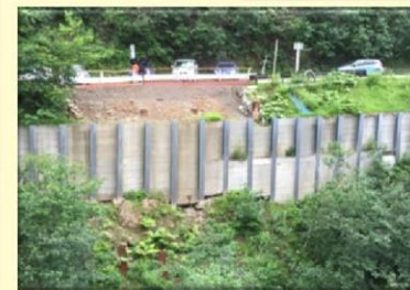
写真B:既設自立式山留式擁壁
