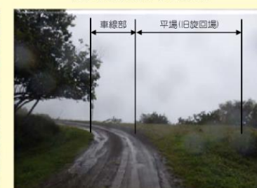
写真F:起点側現況平場(旧旋回場)
