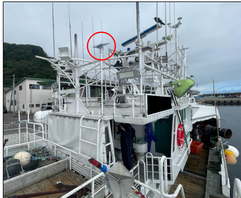
写真:羅臼地区 漁業船スターリンク・ミニ設置
