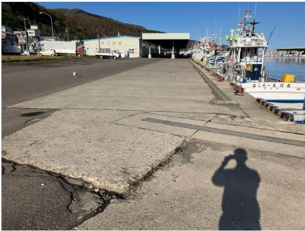
着工前 (-4.0m 岸壁 (改良))
