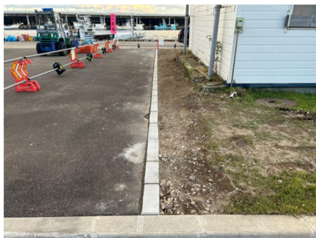
竣工後（用地(改良)）
