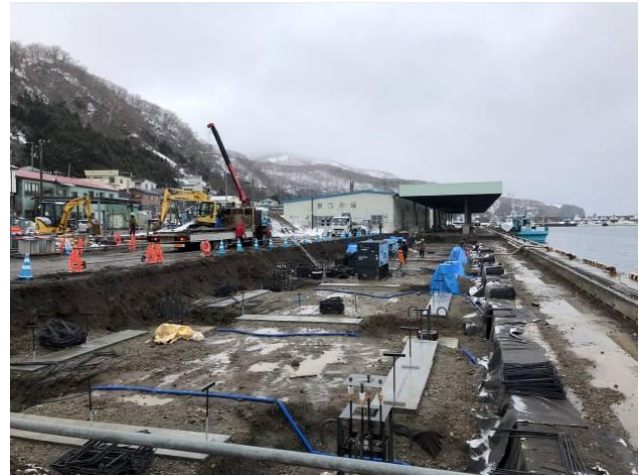
竣工後 (-4.0m 岸壁 (改良))
