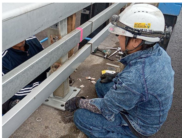
支柱取付状況
