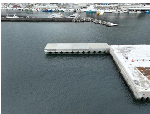
竣工後(波除堤)
