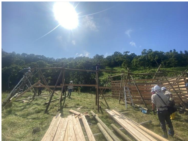
柵の設置作業の様子
