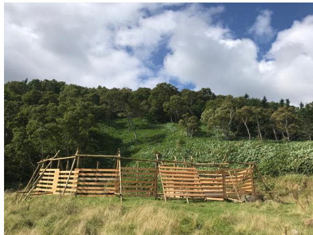
完成した新設柵
