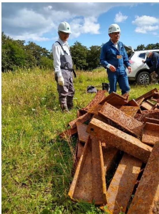
図4. 知床の世界遺産に位置するオッカバケ川のダム改良を担当する林野庁森林管理署の代表者。現場の作業者は、鋼鉄製のダムを細かく切断して、バックパックに入れて、後の集荷のために下流の置き場まで運ぶ。（©IUCN/Peter Rand）
