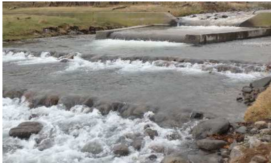
写真1 H28年(2016)石組落差解消
