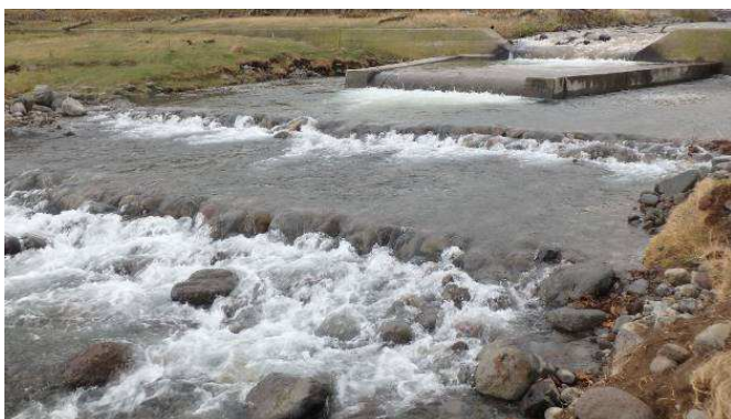
写真左：ルシャ川第一ダム下流の落差解消
