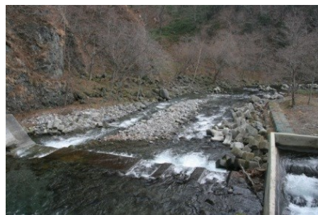
第2ダム下流の状況（改良後）
