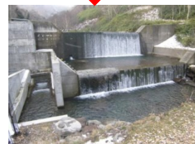
第 1 ダム副ダム再改良後
