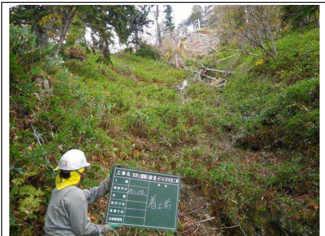
雪崩予防柵着工前
