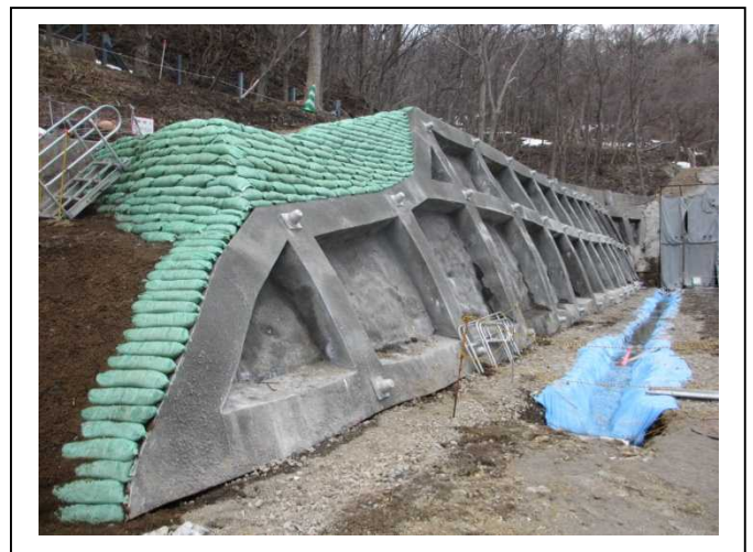
トンネル坑口切土工着工後
