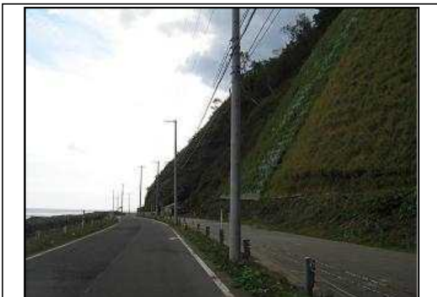
法面工着工前
