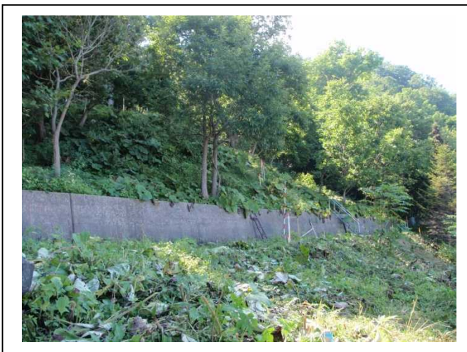
トンネル坑口切土工着工前
