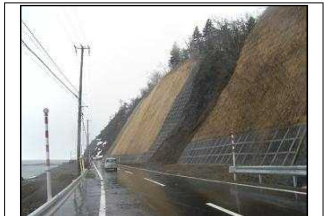
法面工着工後
