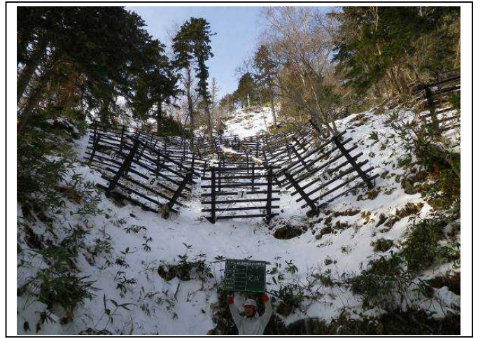
雪崩予防柵着工後
