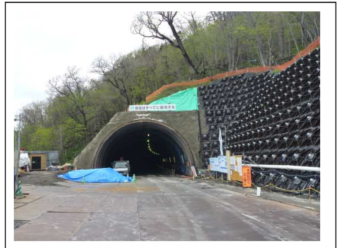
トンネル工着工後
