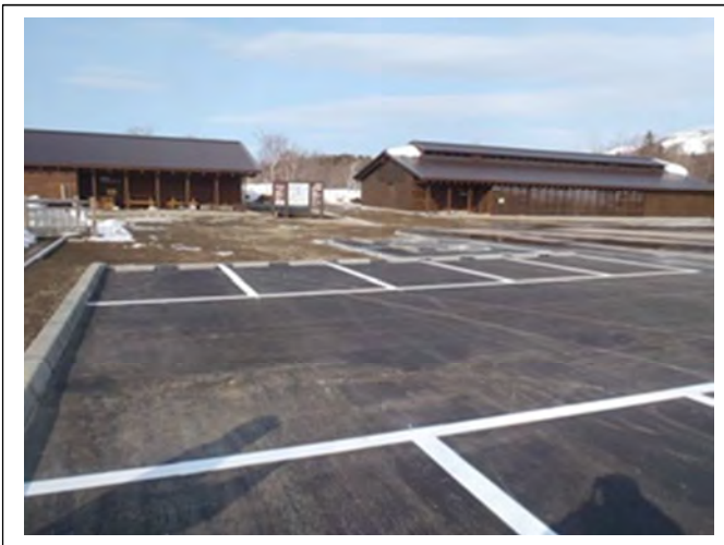
アスファルト舗装工
