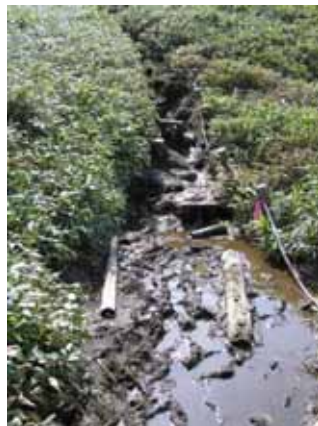
二の沼歩道浸食部の階段補修後
