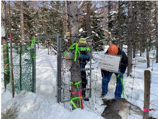
写真 1. シカの進入口及び閉鎖部となる二段式扉の片開きマンゲート
