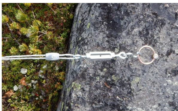
ターンバックル（設置時の写真）
