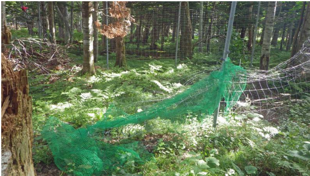
地点 Mo4 (C) : Z型のコーナー部. 2015 年 6 月中旬～8 月にクマが新たに金網を ずり下げた. シカ侵入可.
