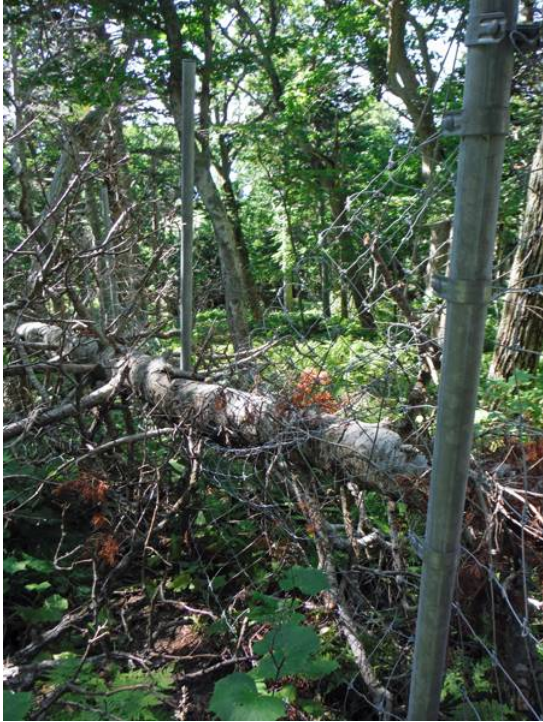
地点 Mo3 (B) : トドマツ倒木 1 本. 金網 3 スパンズり下がり (2014 年)
