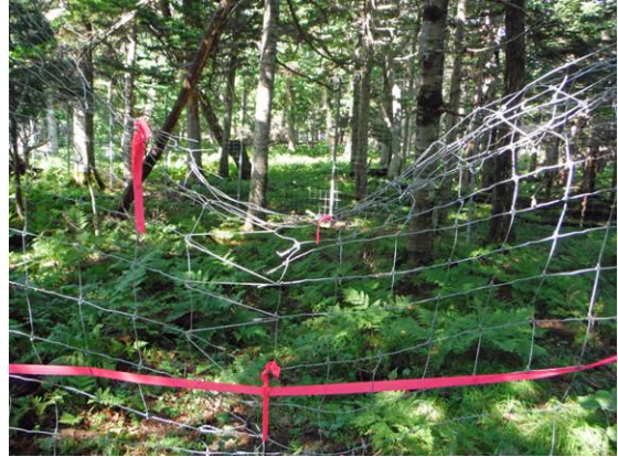
地点 Mo4 : 金網接続部離開 (2014 年)
