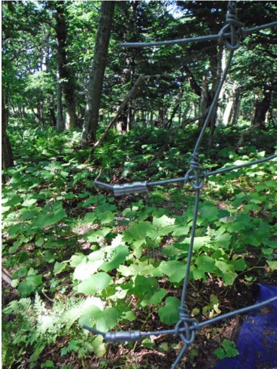
地点 Mo1 : 金網接続部離開 (2014 年)
