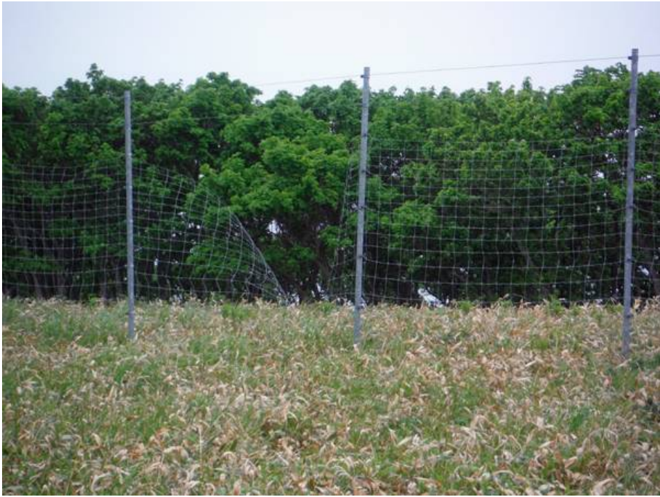
地点 E : 金網接続部が離開. シカ通過可能 (2015 年).
