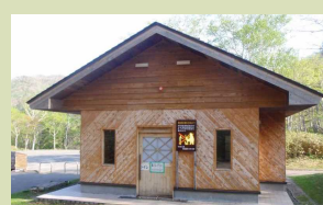
野営場内トイレ
