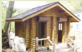
「木下小屋」前のトイレ
